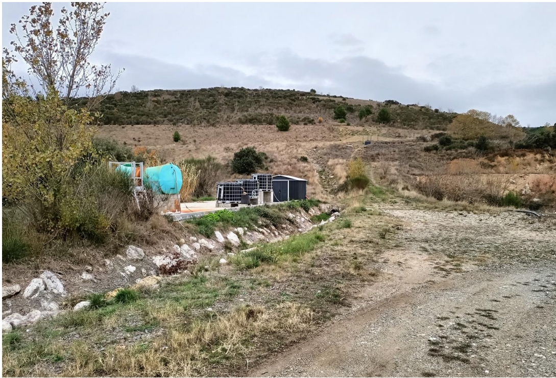
Point d'observation 27 : Fossé aval avec écoulement efficace et végétation coupée
