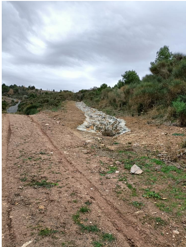
Point d'observation 12: fossé d'évacuation du trop plein du bassin Nord
