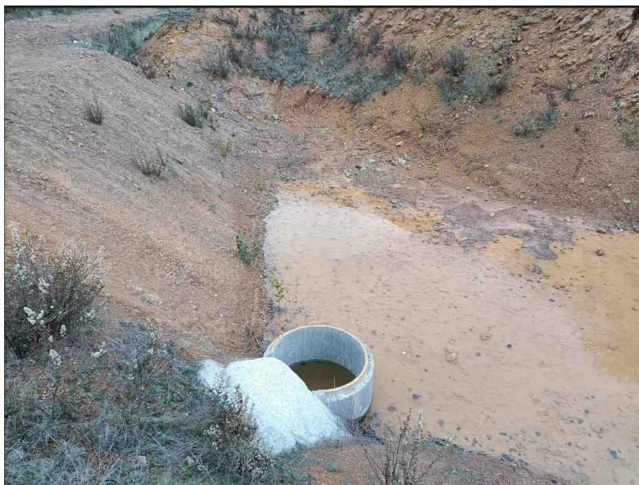
Point d'observation 12: zone d'évacuation de la buse de sortie du bassin Nord (forte érosion)
