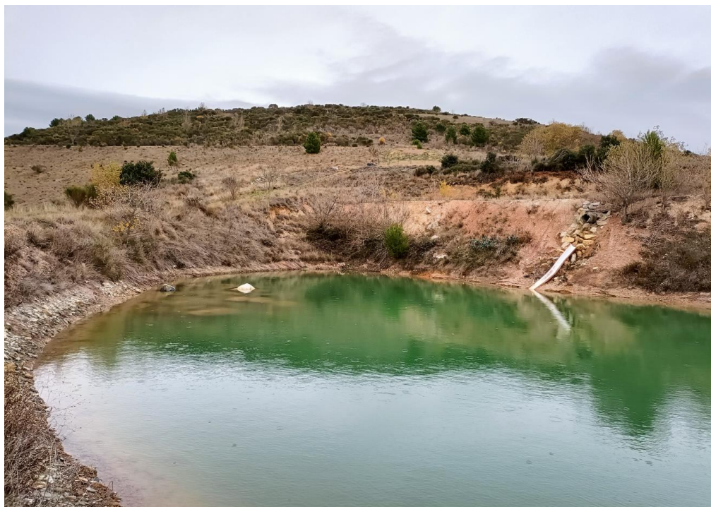
Point d'observation 8 : 4 zones d'érosion décimétriques sur la digue entre les bassins 3 et 4 observées en 2018 n'ont pas évoluées en 2022
