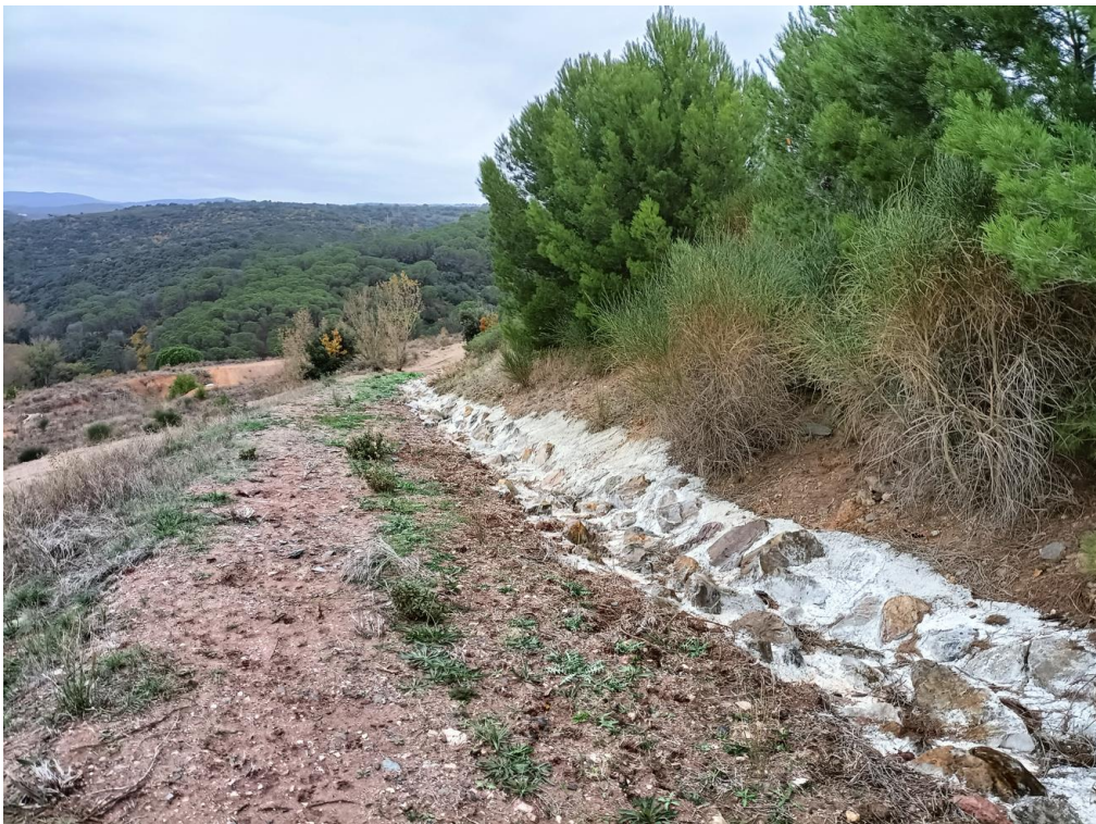
Point d'observation 4 : Fossé terminé et zone d'affleurement de stérile traitée
