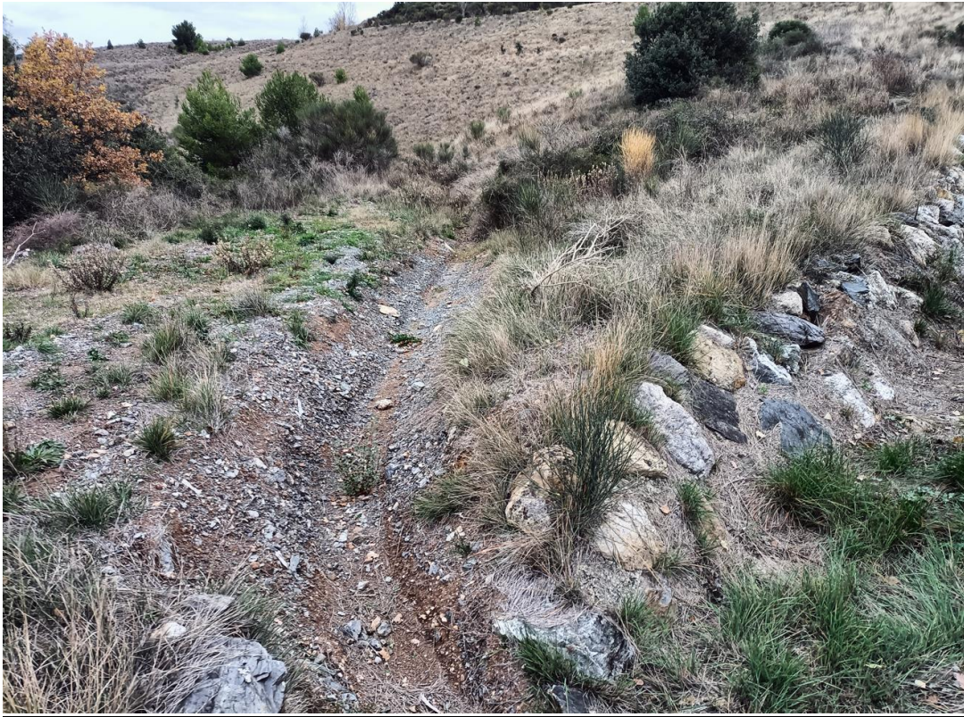
Point d'observation 26 : Fossé reprofilé et évacuation aménagée
