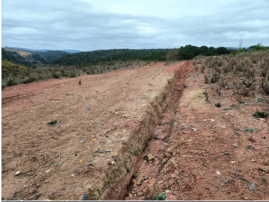
Point d'observation 12: fossé d'évacuation du trop plein du bassin Nord
