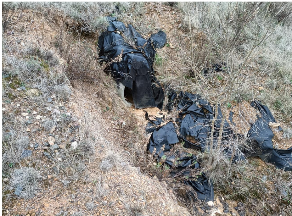
Point d'observation 12: zone d'évacuation de la buse de sortie du bassin Nord (forte érosion)
