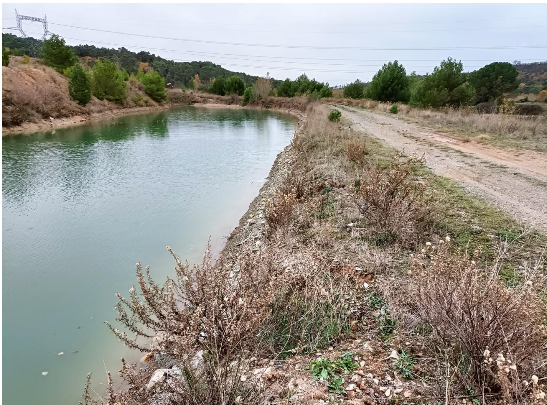
Point d'observation 8 : 4 zones d'érosion décimétriques sur la digue entre les bassins 3 et 4 observées en 2018 n'ont pas évoluées en 2022
